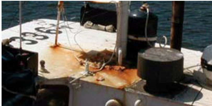
O telhado do telhado em um arrastão.
